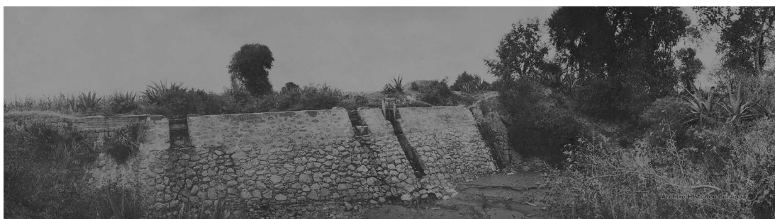
Fotografía 2. La presa Grande de Atoto, 1908.
