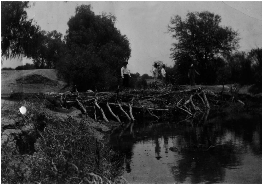
Imagen 1. Presa de estacas, piedras y césped que se construye cada año para tomar agua para el riego, Tlacolula, 1921.
